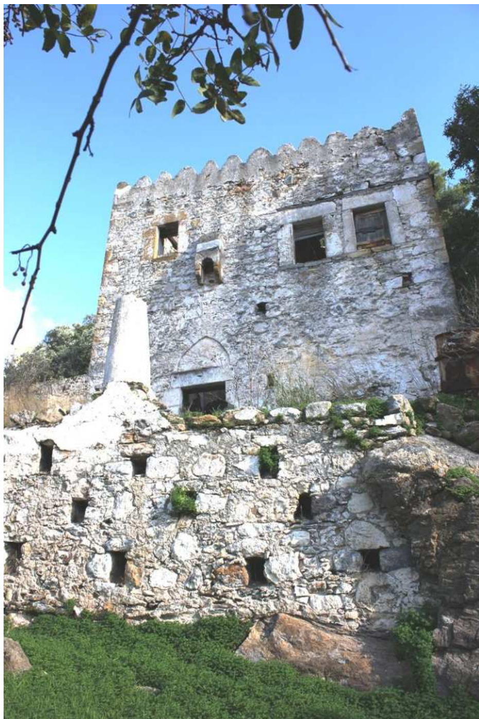
Εικόνα 6.16: Η δυτική όψη του πυργόσπιτου και ο αναλημματικός τοίχος
