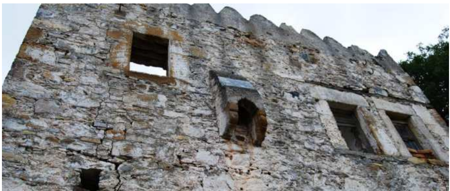
Εικόνα 6.15: Το ανώτερο τμήμα της δυτικής όψης, με την καταχύστρα και τα τρία ανοίγματα. Διακρίνονται και μία από τις τρεις οπές στήριξης της πέργολας
