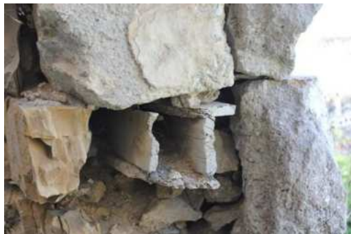
Εικόνα 6.18: Η νότια κοιλότητα όπου ασφάλιζε η οριζόντια μπάρα της εισόδου
