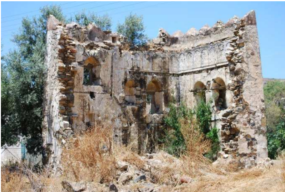
Εικόνα 5.4: Το πυργάκι του Μαρατού όπως είναι σήμερα, άποψη της Ν. πλευράς
