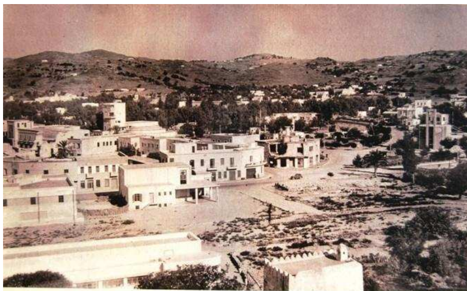
Εικόνα 6.2: Ο οικισμός του Λακκιού (Portolago των Ιταλών), το 1950. Σε πρώτο πλάνο (αριστερά) το κτίριο του σχολείου και δεξιά του διακρίνεται η στέγη του πυργόσπιτου, με τις χαρακτηριστικές οδοντωτές επάλξεις, φωτογραφία Σάββας Φυλακούρης
