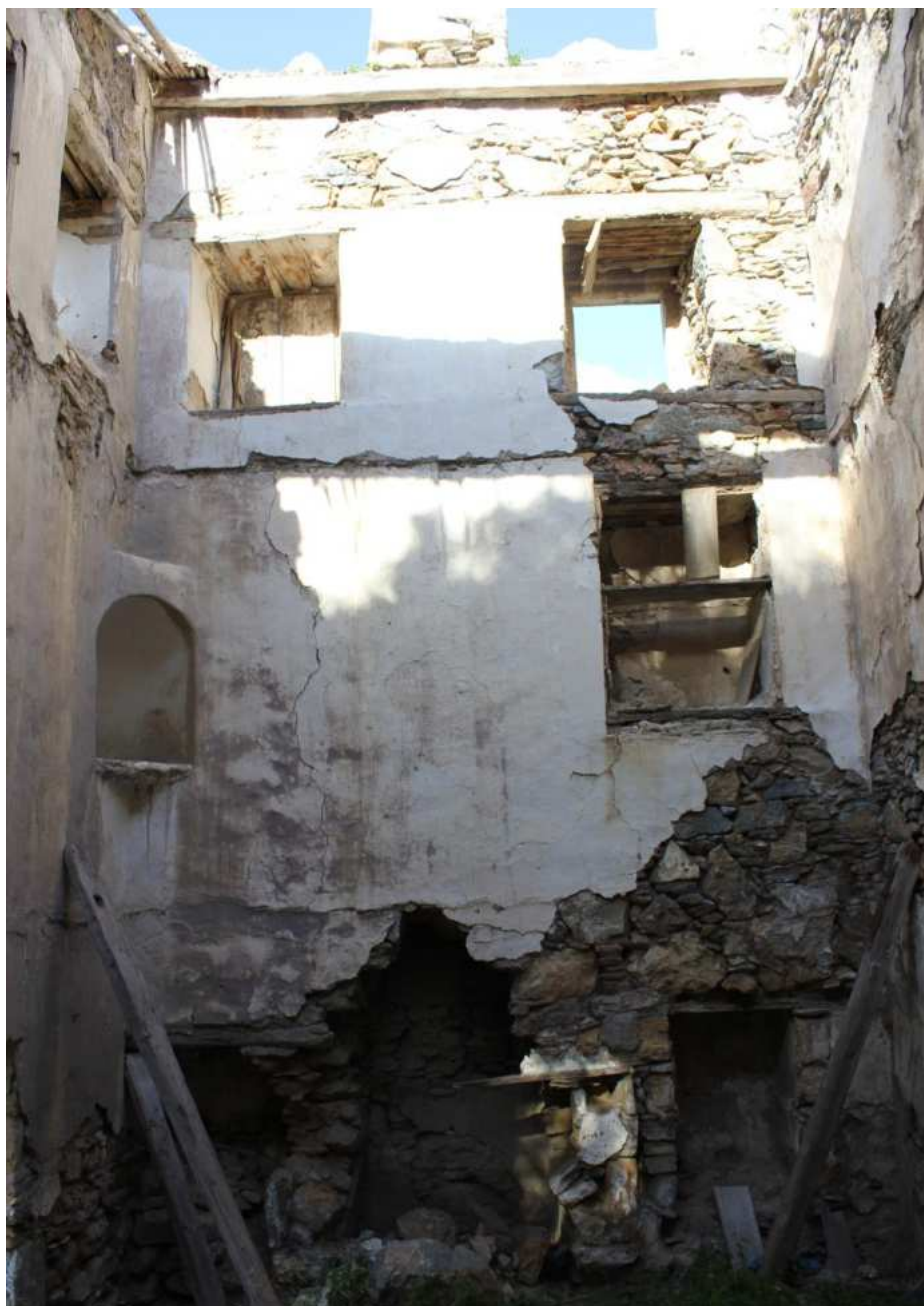
Εικόνα 6.23: Η βορινή πλευρά του ισογείου. Διακρίνονται: το τζάκι με τις εκατέρωθεν εσοχές, τα ίχνη του ορόφου και του παταριού, ο γωνιακός λυχνοστάτης, η μεγάλη εσοχή και τα ανοίγματα ψηλότερα.
