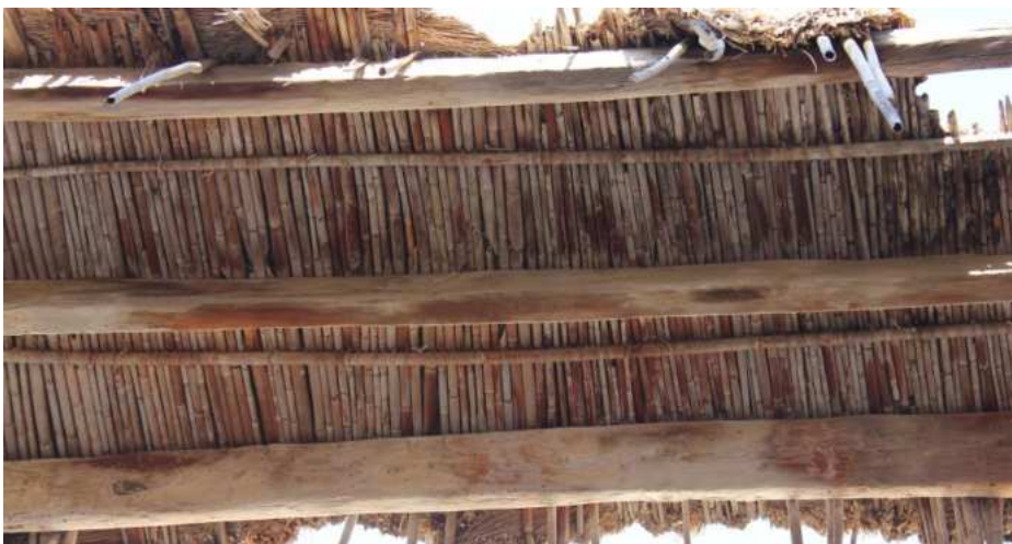
Εικόνα 6.29: Ό,τι έχει απομείνει σήμερα από τη στέγαση του κτίσματος
