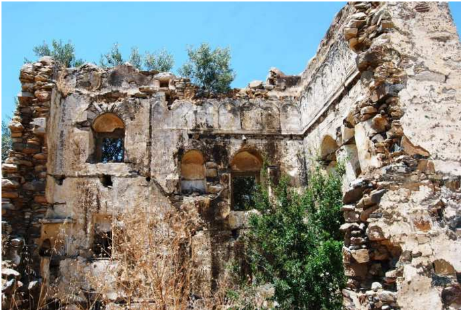
Εικόνα 5.12: Ο βορινός τοίχος εσωτερικά
