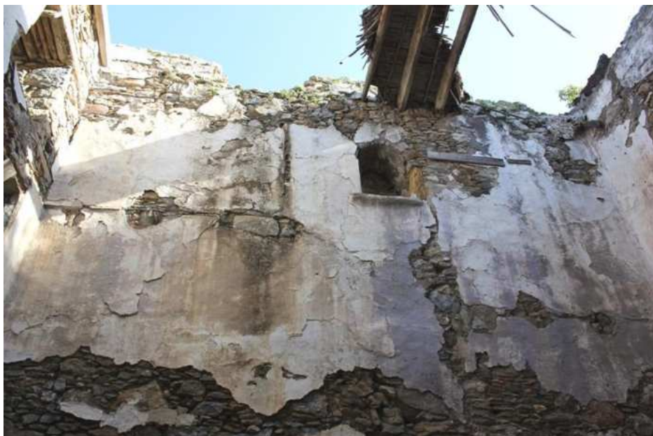
Εικόνα 6.26: Ο ανατολικός τοίχος, με τη μικρή εσοχή-λυχνοστάτη, τα ίχνη των δύο παταριών και της δεύτερης μικρής σκάλας
